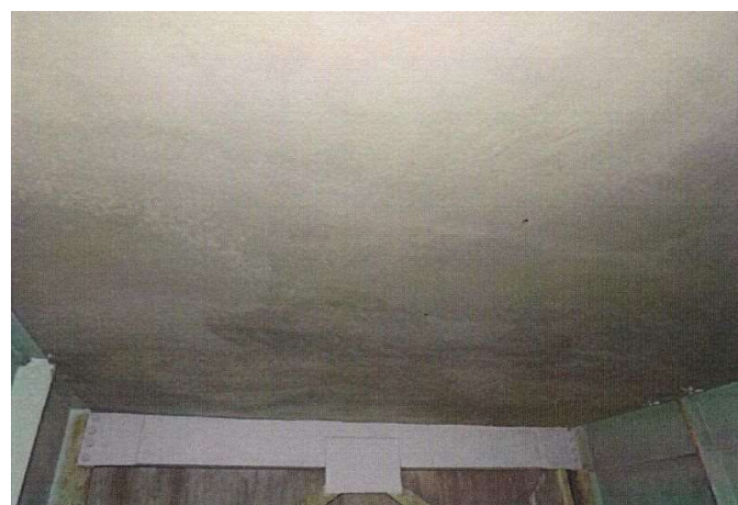
橋梁床版下部増厚工法施工後の状態
