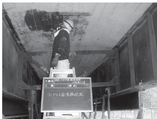
コンクリート面清掃状況
