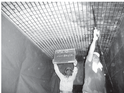
防錆プライマー塗布状況
