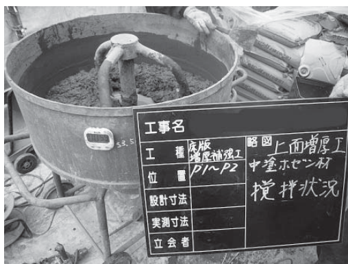
モルタルミキサー材料攪拌状況
