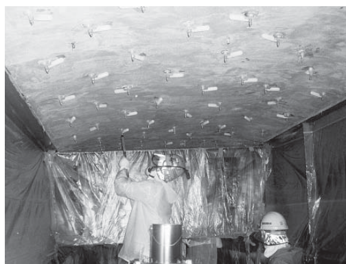
樹脂注入状況
