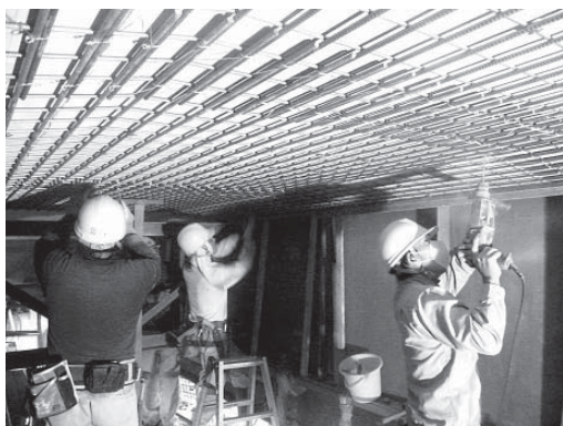
テーパー付 T 型アンカーにて網鉄筋取付状況
