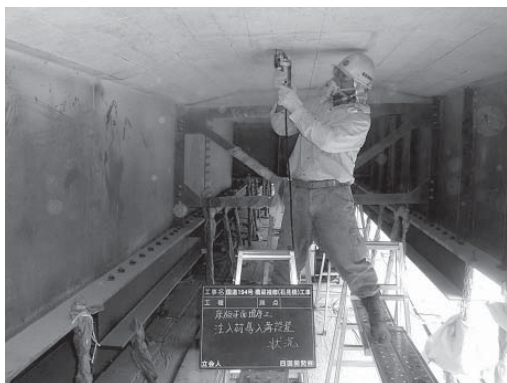
樹脂導入路設置状況
