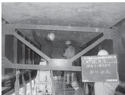
グラウトプラグ A 取付状況
