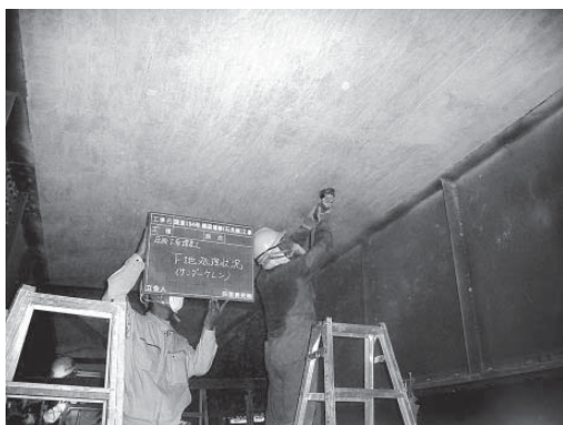
下地処理工：サンダーケレン状況
