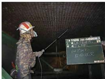
写真4. 防錆プライマーの塗布
