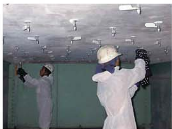
写真6. 超低粘度エポキシ樹脂の注入
