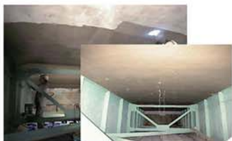
写真7. ホゼンコート材塗布による仕上げ
