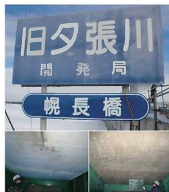
写真8. 施工事例（幌長橋・江別長沼線）
