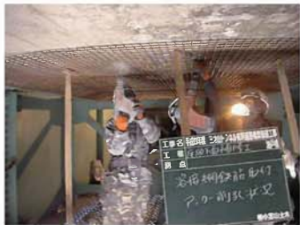
写真3. 「テーパー付きT型アンカー」での網鉄筋の圧着固定の様子
