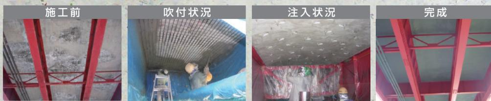
既設床版と増厚材を確実に一体化させる、**3段階の対策工程**をご覧ください。
