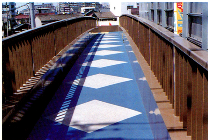
模様入り橋面舗装工 t=8mm
