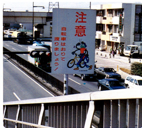
アルミ板・反射シート貼付
